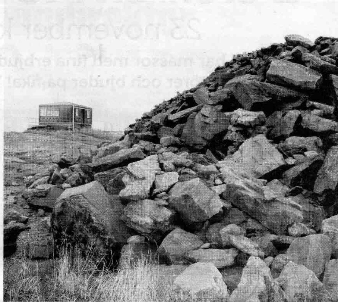
TUNGT. Tusentals ton stenmassor i väntan på att bli till en längre pir.
